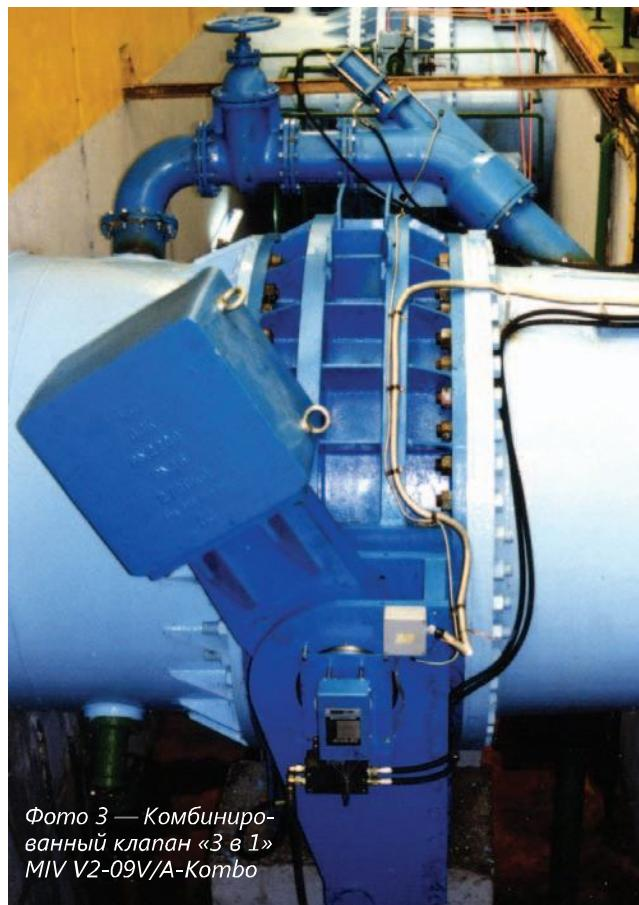
Фото 3 — Комбинированный клапан «3 в 1» MIV V2-09V/A-Kombo
