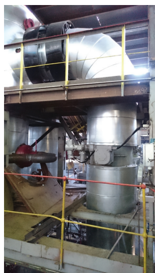
Фото 4 — Дисковый затвор Ду1000, установленный после обратного клапана на паропроводе НД Ду1000
