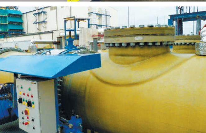
Рисунок 6 — Панель (шкаф) управления клапана аварийного закрытия MIV
