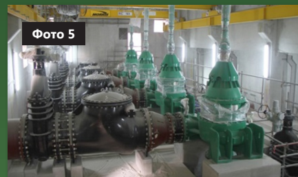
Фото 5. Насосная станция в Дохе (Катар) с задвижками и обратными клапанами MIV DN1000
